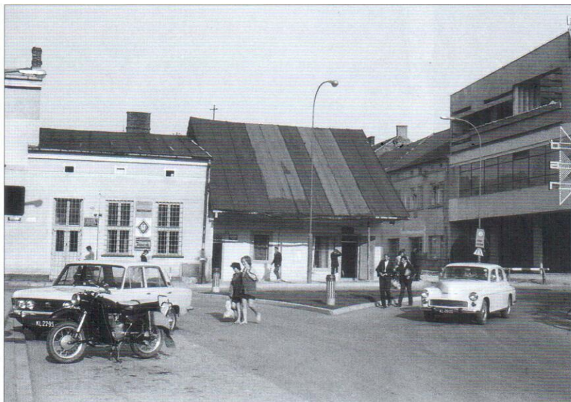
Budynek Banku Spółdzielczego w Limanowej (z lewej) - początek lat siedemdziesiątych XX w.
