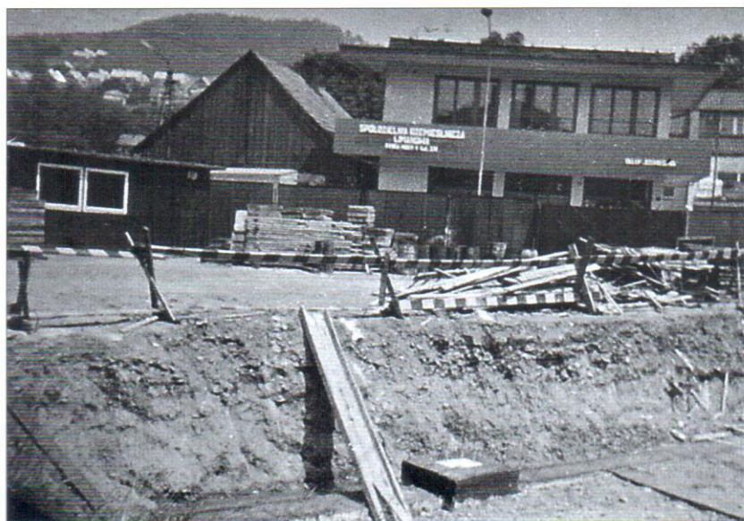
Budowa nowej siedziby banku - rok 1988.
